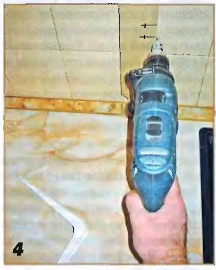
Отверстия в кафельной плитке сверлил обычной дрелью с алмазным сверлом.
