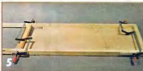
5 Для сборки каркаса боковой стенки шкафа используют большие струбцины и боковину в качестве проставки.
