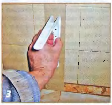
Установку кронштейнов начал с примерки.
