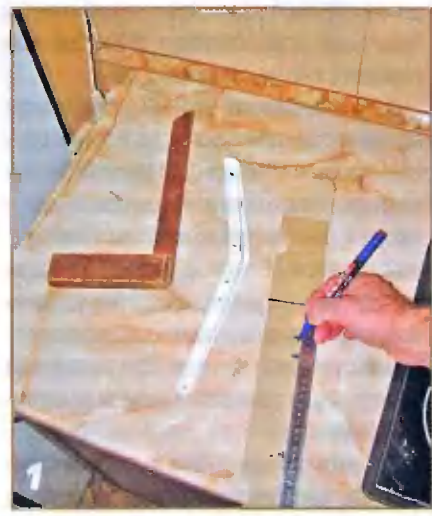
Для точной разметки отверстий в стене для крепления кронштейнов я изготовил шаблон из куска картона.
